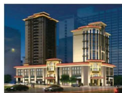
总部大楼 Здание штаб-квартиры
